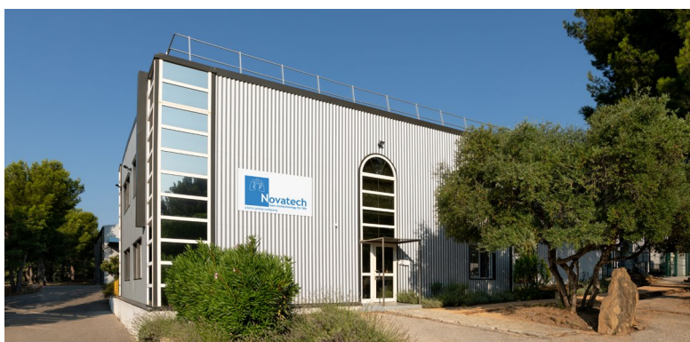
Bureaux, production et entrepôt à La Ciotat, dans le sud de la France
